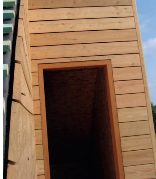
Afb. 36 Ope- werke plaatsing.
