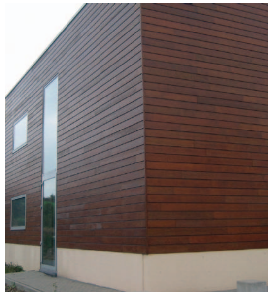
Afb. 61 Voorbeeld van een afwerking aan de voet van een houten gevelbekleding.
