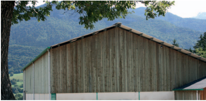
Afb. 24 Houten gevelbekleding waarvan het hout behandeld werd in een autoclaaf met behulp van producten die metaalzouten bevatten.
