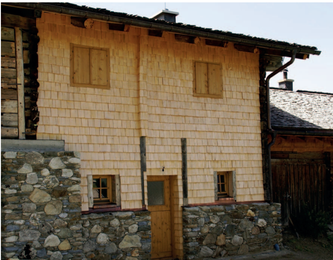
Afb. 10 Gevelbekleding uit gezaagde houten leien (shingles).
