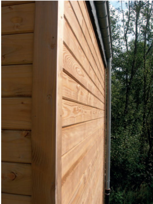
Afb. 48 Afwerking van de zijrand van een houten gevelbekleding.
