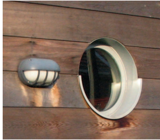
Afb. 60 Voorbeelden van te vermijden toegevoegde elementen.
