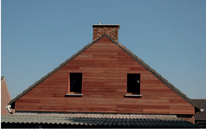
Afb. 35 Plaatsing met tand en groef.
